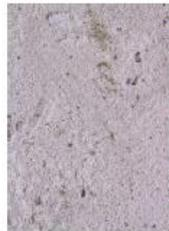
Enduit de plâtre uniforme graté fin : plâtre gros, un peu de chaux aérienne, sable et charbon de bois
